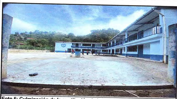
Foto 5: Culminación de la sustitución de losa del patio del establecimiento.
